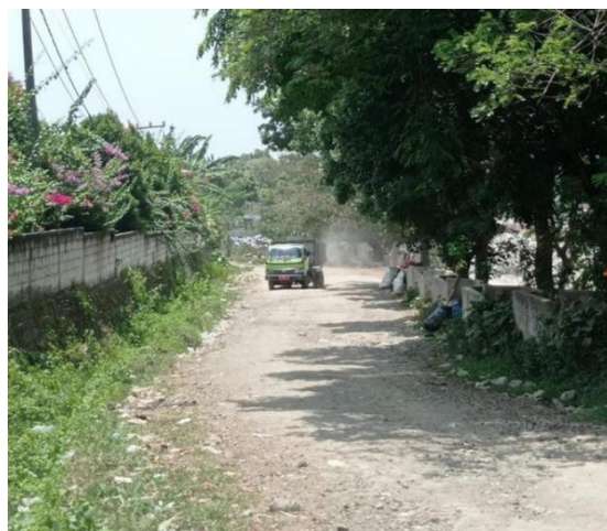
Gambar 5. Foto Jalan Lokal Primer Akses TPST Maja KSP Bendungan Karian
